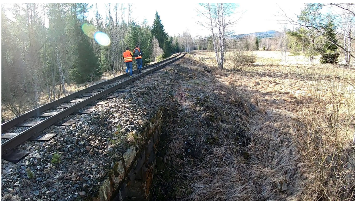
Obr. 10: Nevyhovující šířka drážní stezky v km 83,400 - pohled po směru staničení
