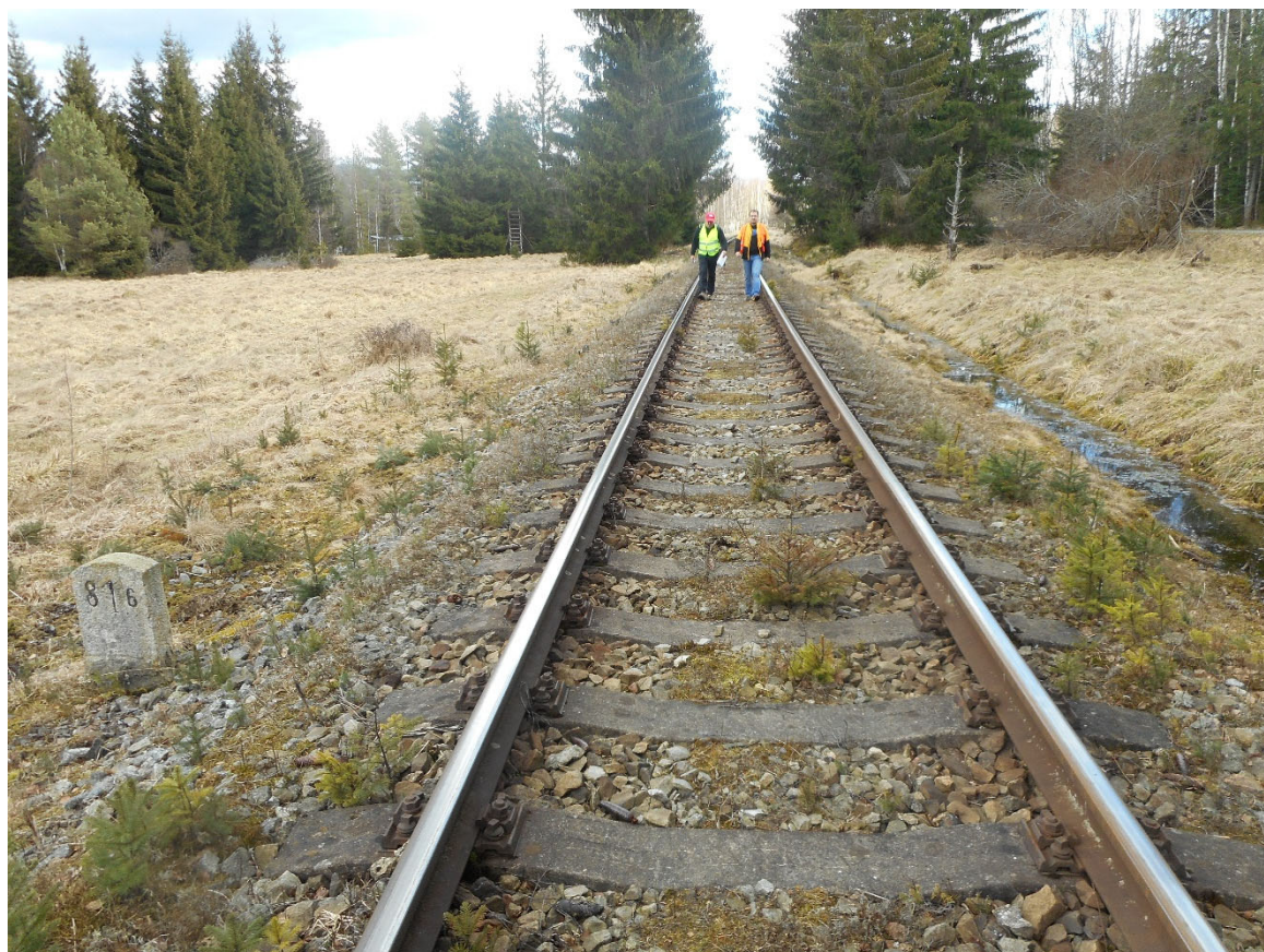
Obr. 4: Nevhovující odvodnění v km 81,600 - pohled proti směru staničení
