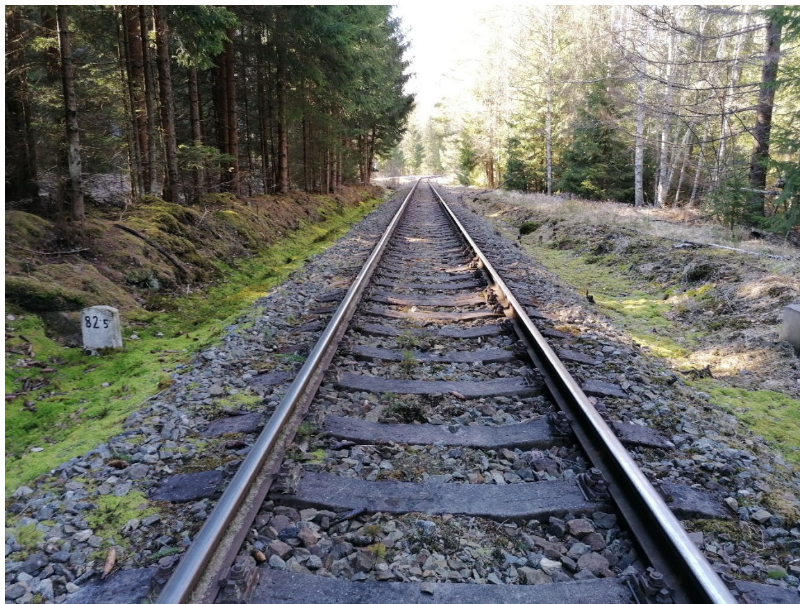
Obr. 6: Nevhovující odvodnění v km 82,500 - pohled po směru staničení
